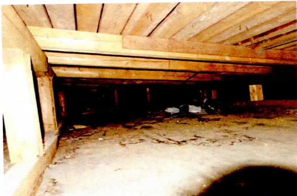
1,2 pohled do podstřeší dvouplášťové střechy
