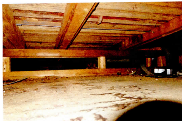
3,4 patrné stopy po občasném zatečení vody na asfalt. pásu, detail prostupu vtoku
