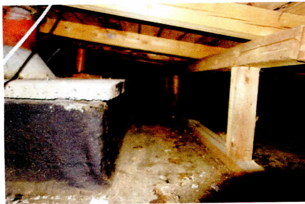
5,6 stav u vzduchotechnické šachty, na prkně známka po občasném zatečení
