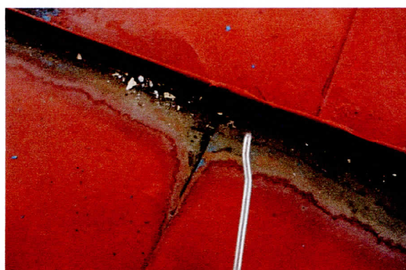
21,22 v těchto spojích je možné vztlínání a zatékání vody, počáteční koroze
