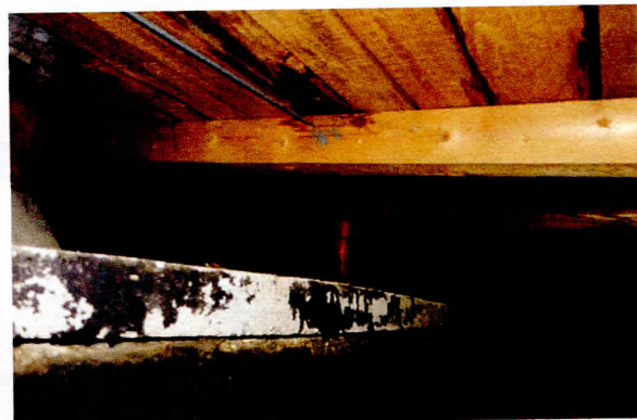
5,6 stav u vzduchotechnické šachty, na prkně známka po občasném zatečení
