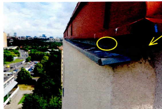
15,16 okapnice na zateplení štítu, uvolněná hmoždinka a neukončený detail spáry = možné zatékání
