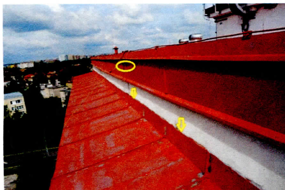
13,14 chybějící dilatační lišta u oplechování stříšky, uvolněné upevnění okraje – hřebík
