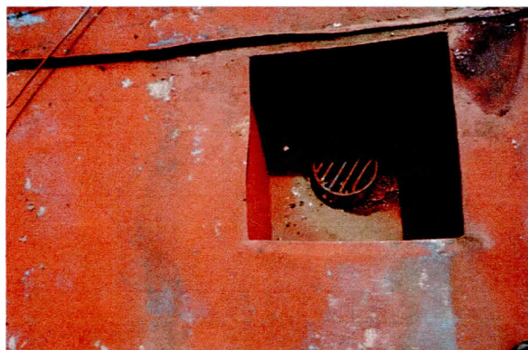
19,20 okolí vtoku s nízkým sklonem, nečistoty za strojovnou
