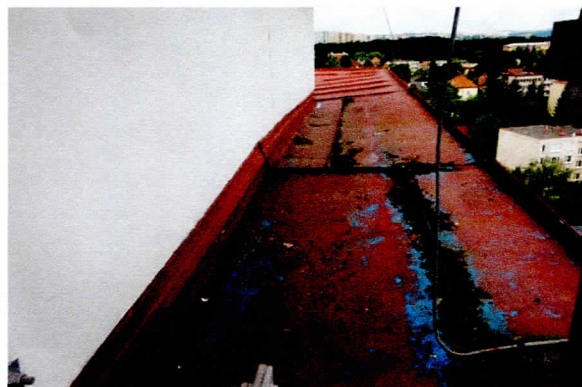
19,20 okolí vtoku s nízkým sklonem, nečistoty za strojovnou
