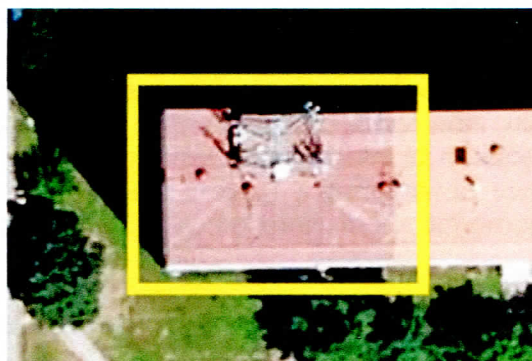
Snímek kontrolované střechy
