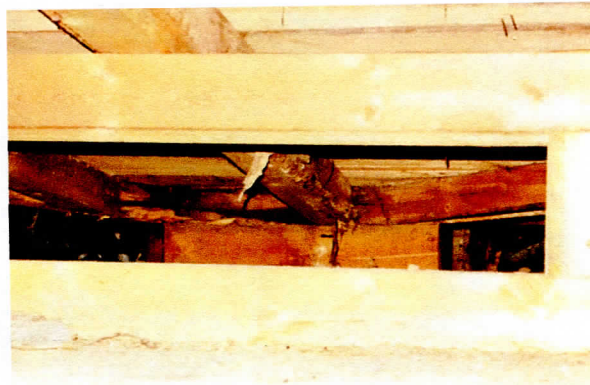
3,4 patrné stopy po občasném zatečení vody na asfalt. pásu, detail prostupu vtoku
