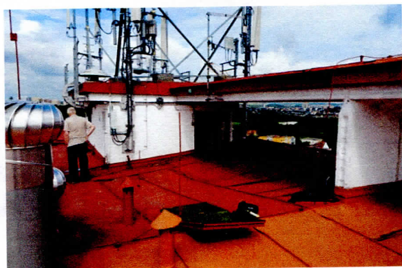
5,6 stav u vzduchotechnické šachty, na prkně známka po občasném zatečení
